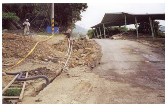
照片一 大里垃圾掩埋場入口之道路受 逆斷層抬升約 2 公尺情形 (地調所，2000)
